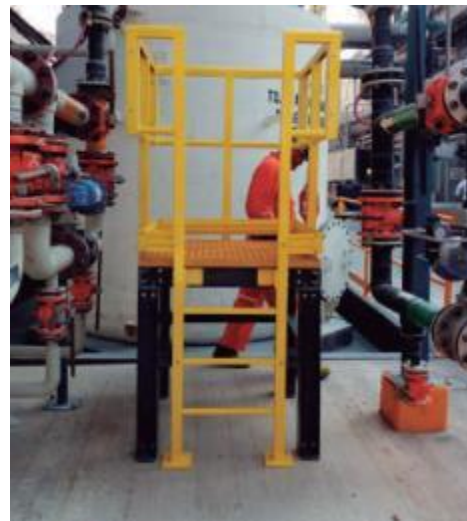
PLATAFORMA PARA ACCESOA VÁLVULAS
