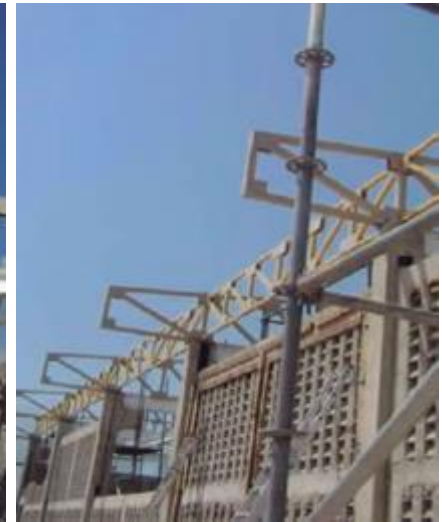
CABRILLAS PARA TECHUMBRES ARMADAS DE PERFILES ESTRUCTURALES DE FIBRA DE VIDRIO
