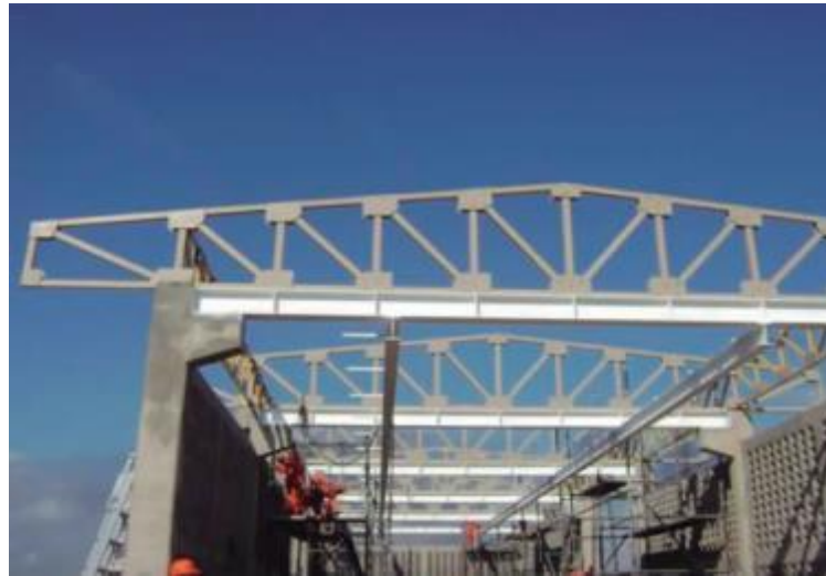
CABRILLAS PARA TECHUMBRES ARMADAS DE PERFILES ESTRUCTURALES DE FIBRA DE VIDRIO
